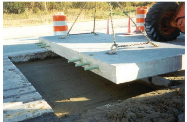
Hình 22 – Thay thế các tấm bê tông xi măng cũ bị hư hỏng bằng các tấm lắp ghép mới
