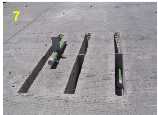
Hình 15 – Các bước thi công bổ sung thanh truyền lực cho khe ngang
