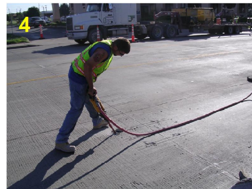
6 - Đáy khe bằng phẳng, sạch sẽ sau khi phun nước làm sạch
