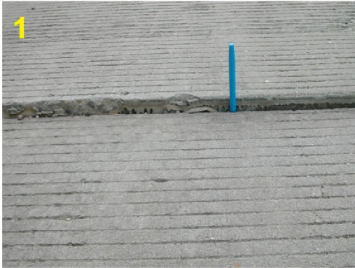
3 - Mặt đường sau khi cắt
