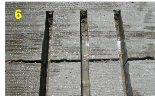
8 - Khe được bảo dưỡng, mài phẳng và rót vật liệu chèn khe
