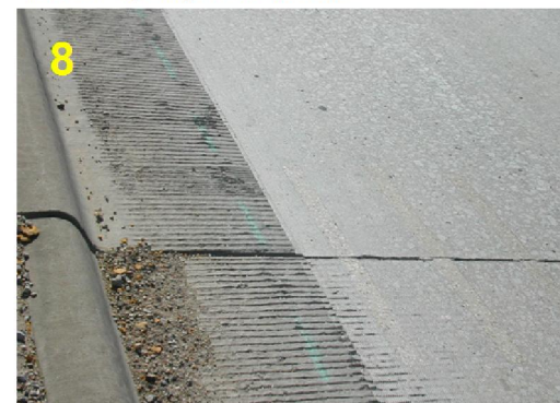
8 - Khe được bảo dưỡng, mài phẳng và rót vật liệu chèn khe
