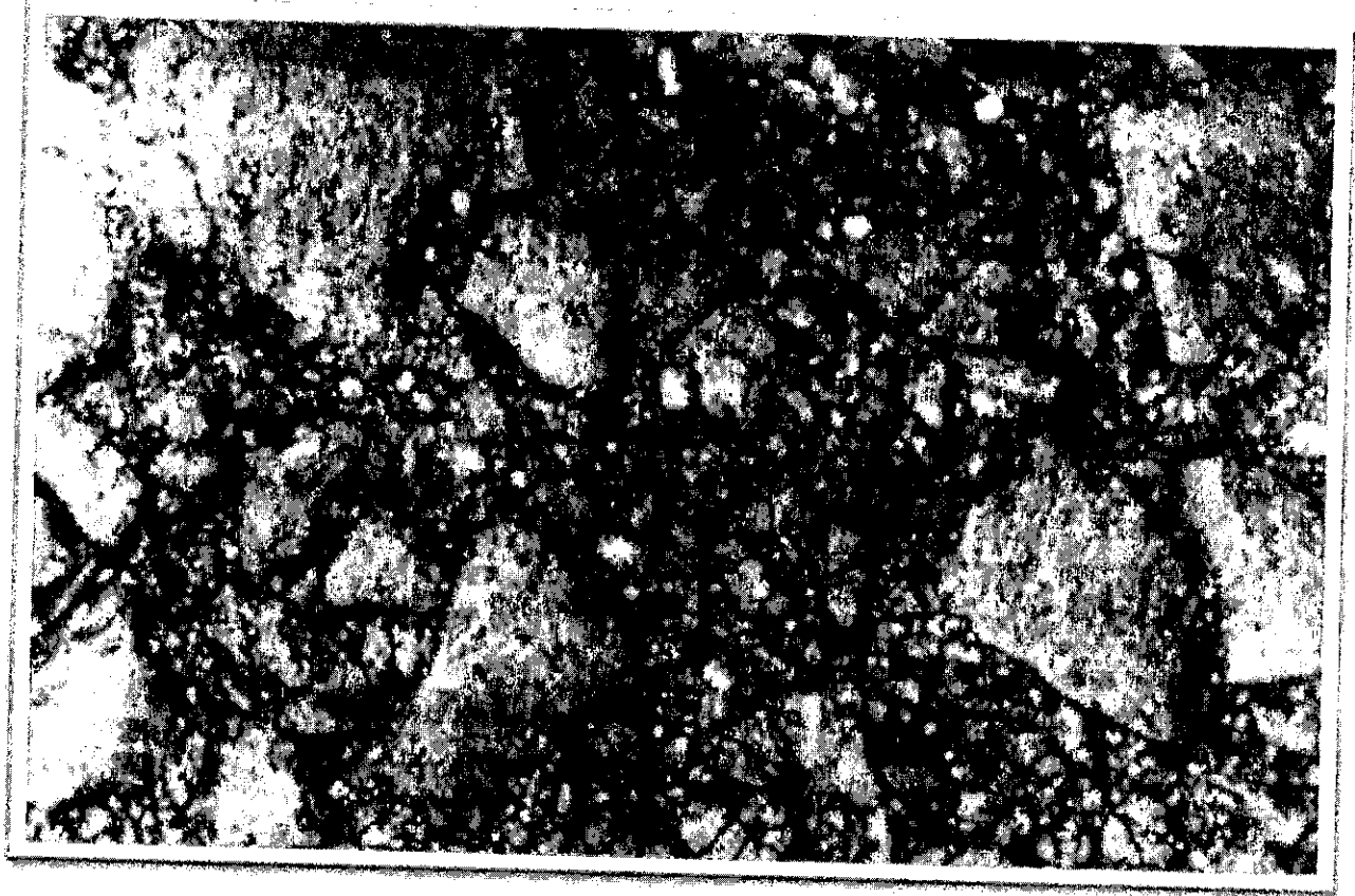
Hình A.1 — Hình ảnh mặt đường sau khi phun bóc
