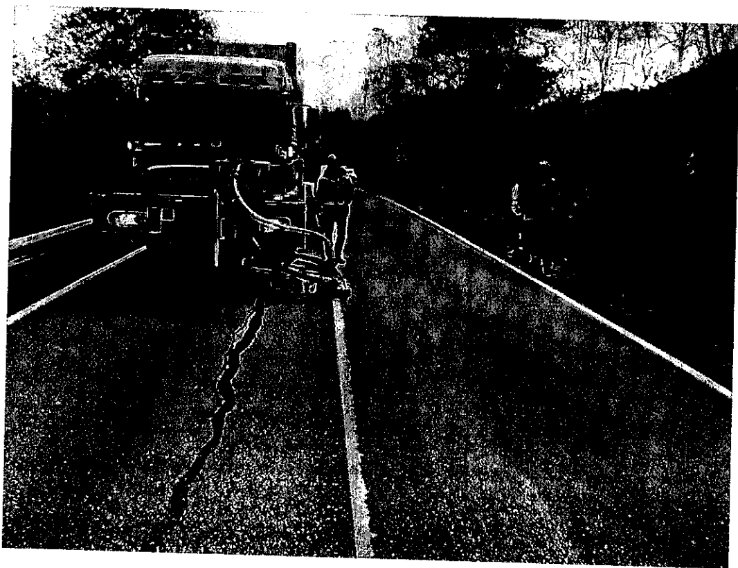
Hình A.2 — Xe thi công xóa vạch kẻ đường theo phương pháp phun bóc
