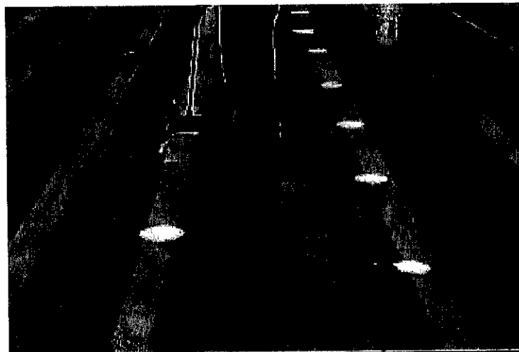
Hình A.9 — Sử dụng dung môi xóa vạch kẻ đường
